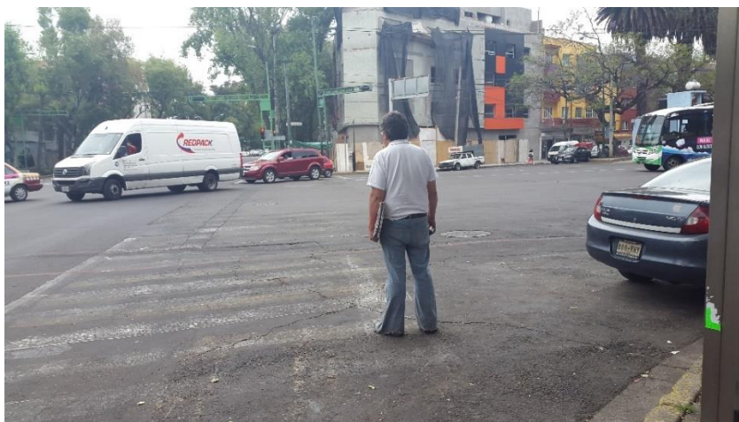
Figura 4. Señalamiento horizontal: paso de cebra poco visible
